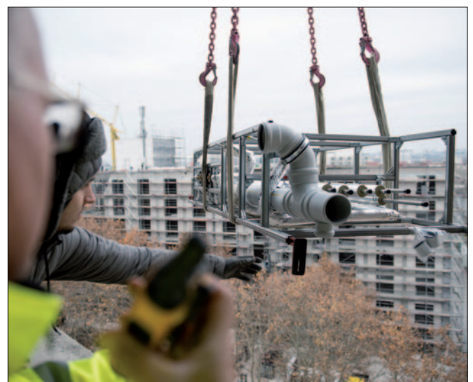
Modulares Bauen 2: Vorgefertigte Installationswände und -Schächte für HLS Installation.
