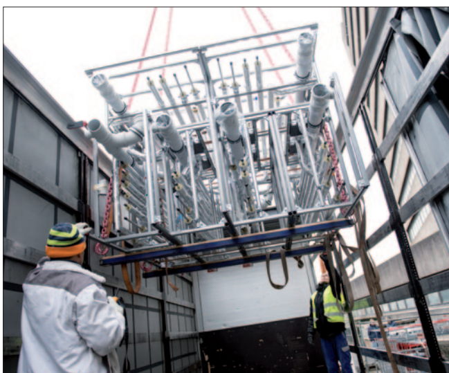
Modulares Bauen 2: Vorgefertigte Installationswände und -Schächte für HLS Installation.
